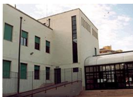
"Basilio Cascella" Piazza Di Grue
